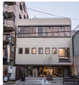
HOSTEL NINIROOM外観
